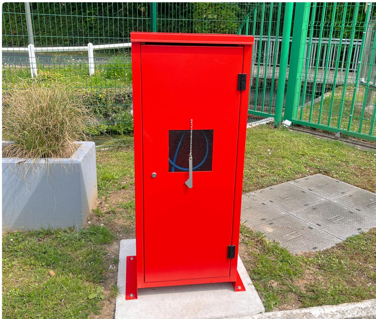
L'**obturateur anti-pollution gonflable** est un dispositif de sécurité destiné à **empêcher les eaux polluées** (issues d'un incendie ou d'un déversement accidentel) **de rejoindre le milieu naturel ou les réseaux d'assainissement**. Il permet la mise en **réétention temporaire des eaux directement dans les canalisations du site**, en utilisant ces dernières comme **zone tampon de stockage**.
