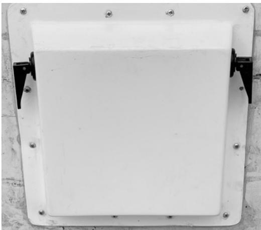
En cas de risque d'inondation, il suffit de mettre rapidement les deux bouchons de compressions (en plastique et caoutchouc) sur chaque cotés pour le rendre totalement étanche.
